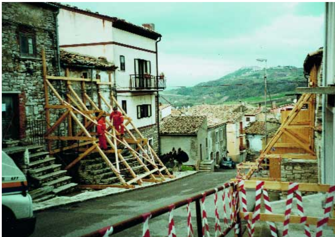
Ripabottoni, uno dei paesi più colpiti dal terremoto. Gli alpini hanno provveduto a mettere in sicurezza decine di case.
