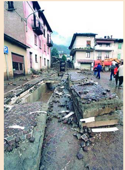
Ardenno: la piazza dopo l'alluvione.
