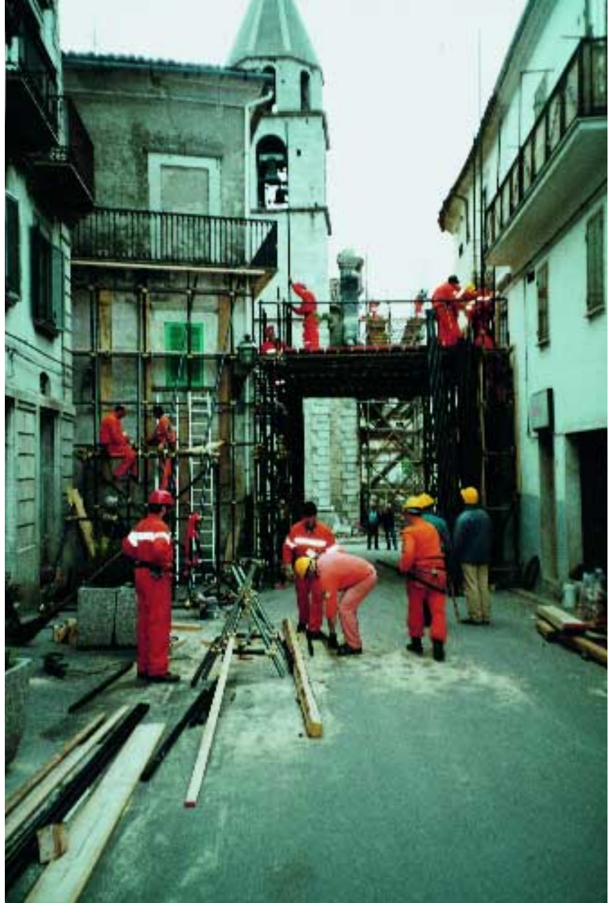
Al lavoro per garantire la sicurezza delle abitazioni e il transito di pedoni e veicoli.
