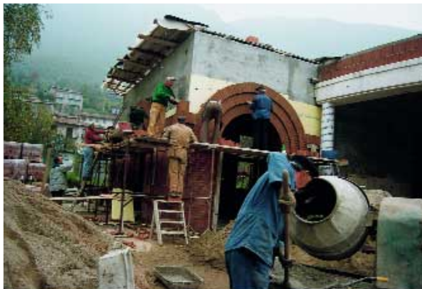
Il laboratorio per disabili di Endine Gaiano in costruzione.
